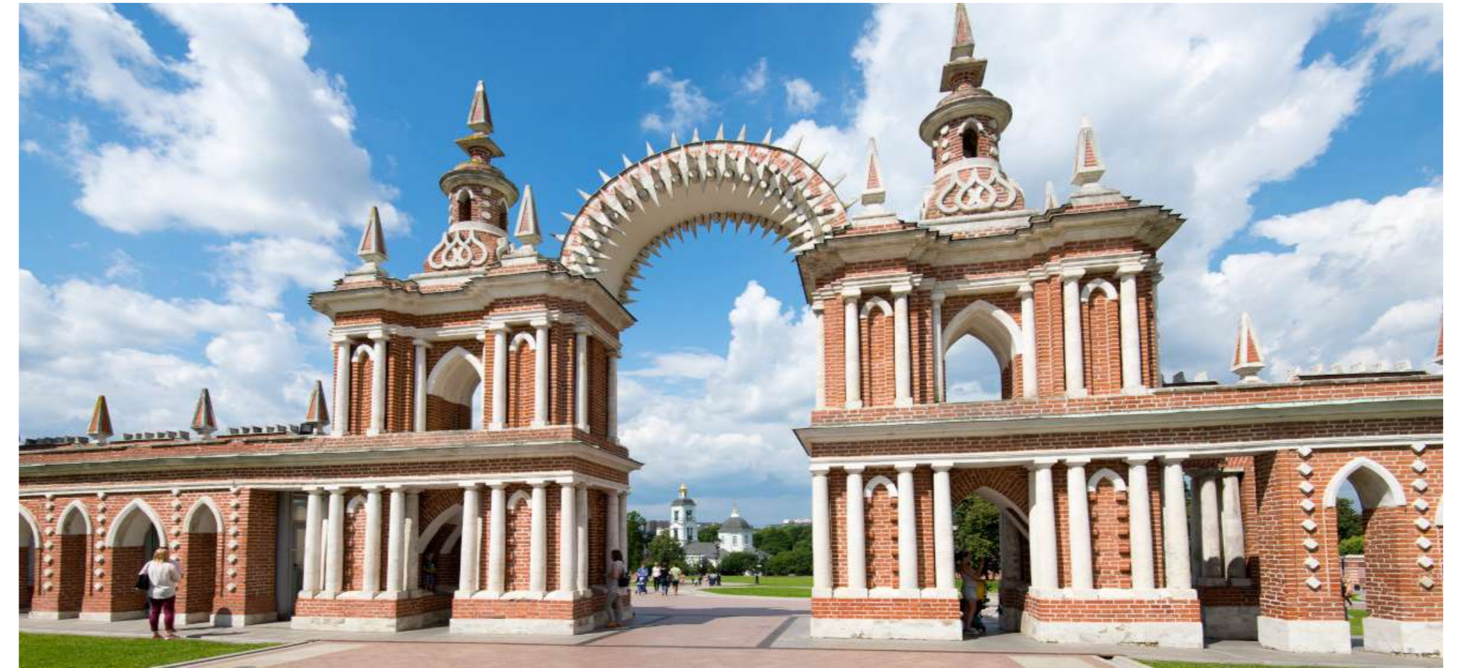
Обследование здания государственного историко-архитектурного, художественного и ландшафтного музея-заповедника «Царицыно» (г. Москва, ул. Прохладная д.1).
