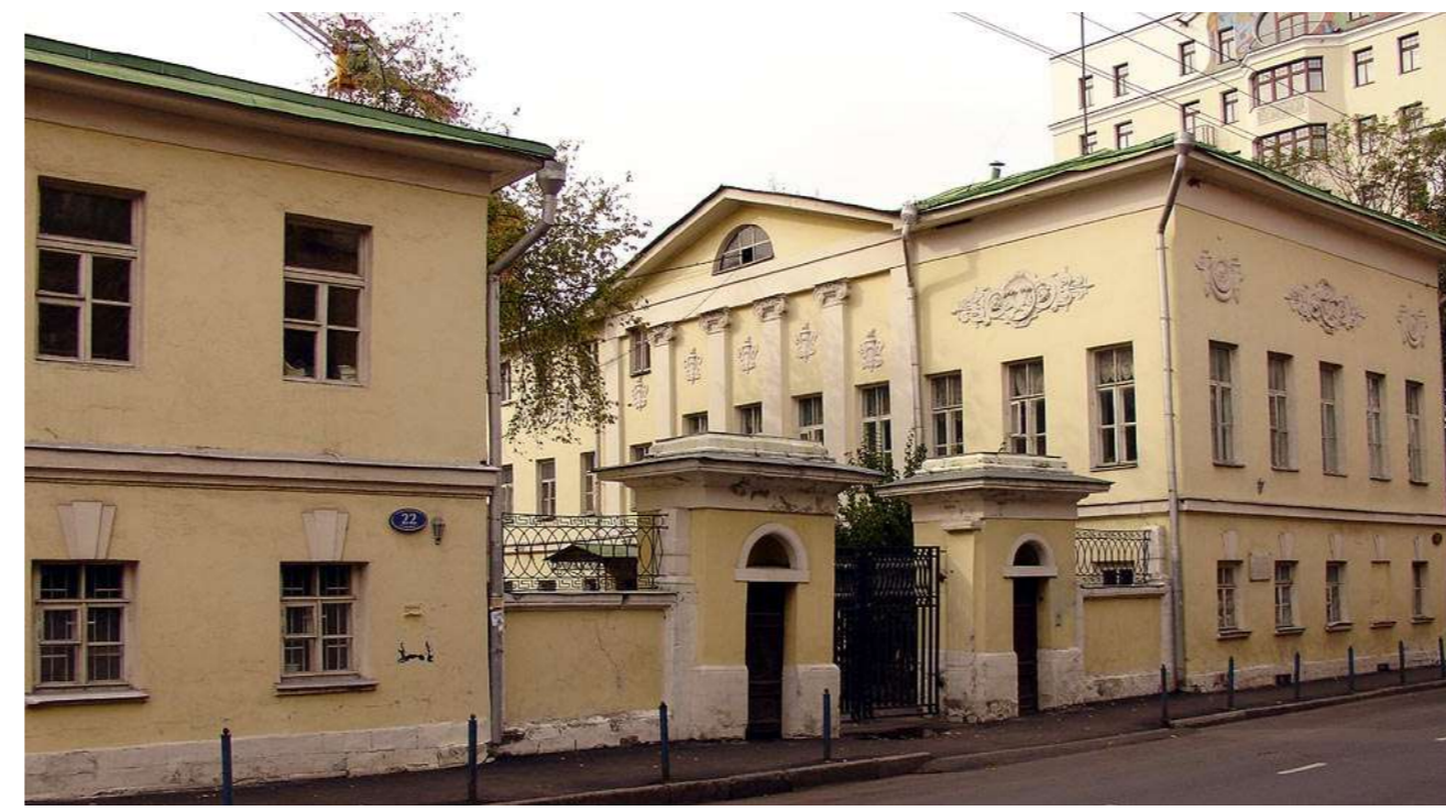
Обследование и разработка контраварийных мероприятий по объекту культурного наследия федерального значения «Усадьба, начало XIX в.: дом с боковым флигелем, ограда с воротами, церковь» по адресу: г. Москва, Старомонетный пер., д. 22, стр. 1, 2, 3
