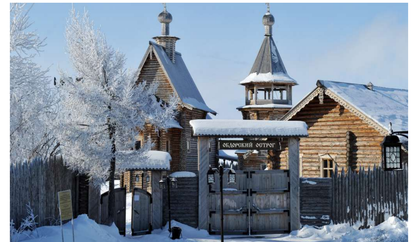
Обследование строительных конструкций и моделирование влияния существующих зданий историко-архитектурного коимплекса «Обдорский острог» на устойчивость грунтового массива оболочки зимника
