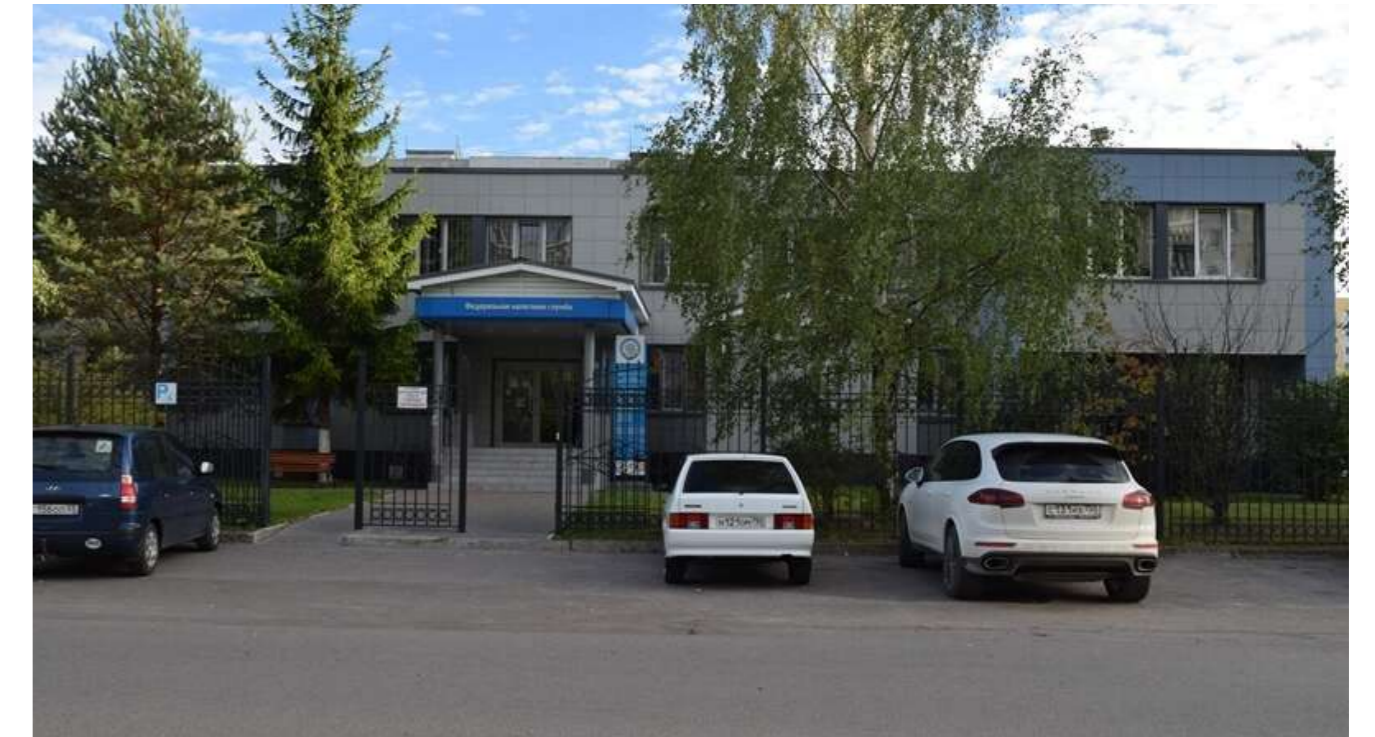
Разработка рабочей документации на капитальный ремонт межрайонной ИФНС России № 10 Московской области расположенного по адресу: г. Орехово-зуево, ул. Северная, д.12в
