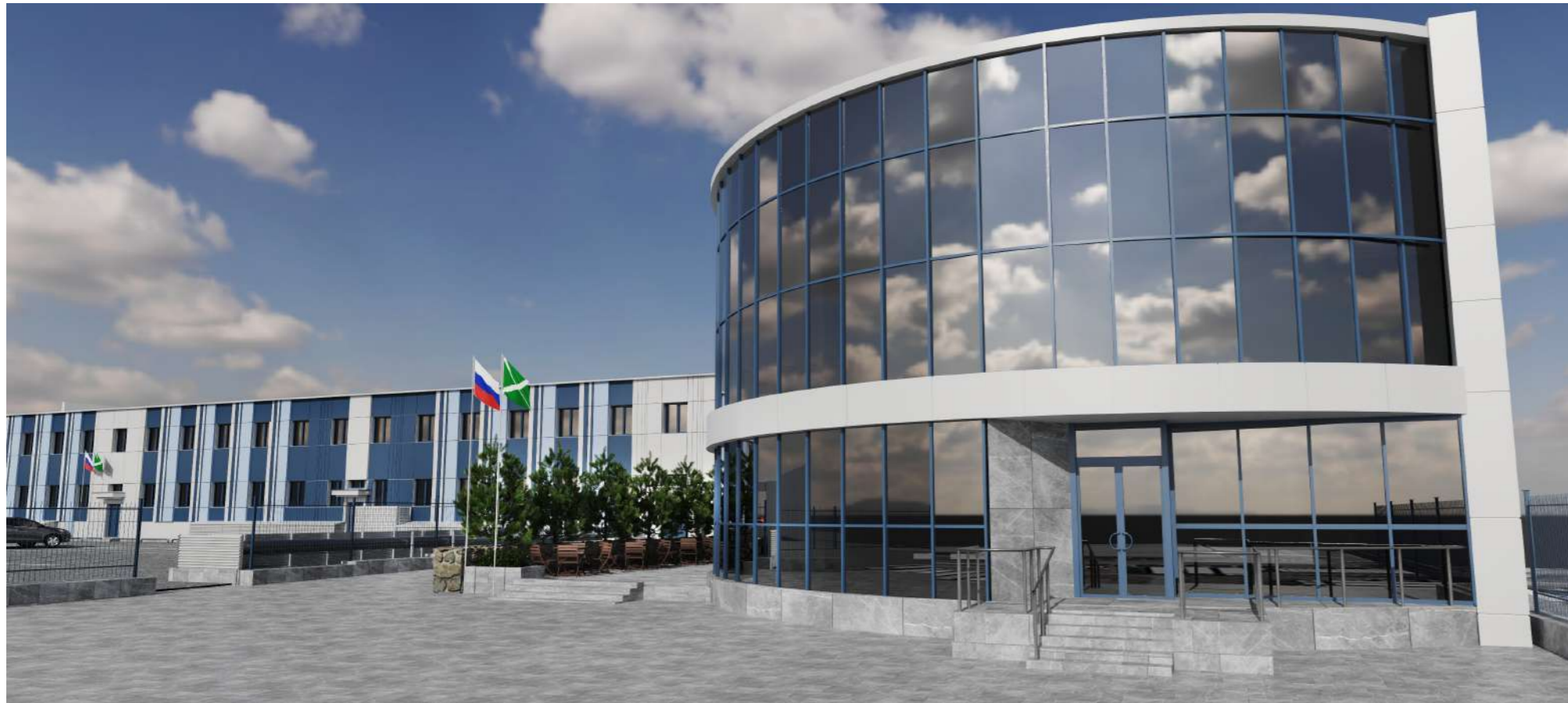
Обследование фасадов таможенного терминала по адресу: Московская область, г. Химки, ул. Вашутинское шоссе, д. 20
