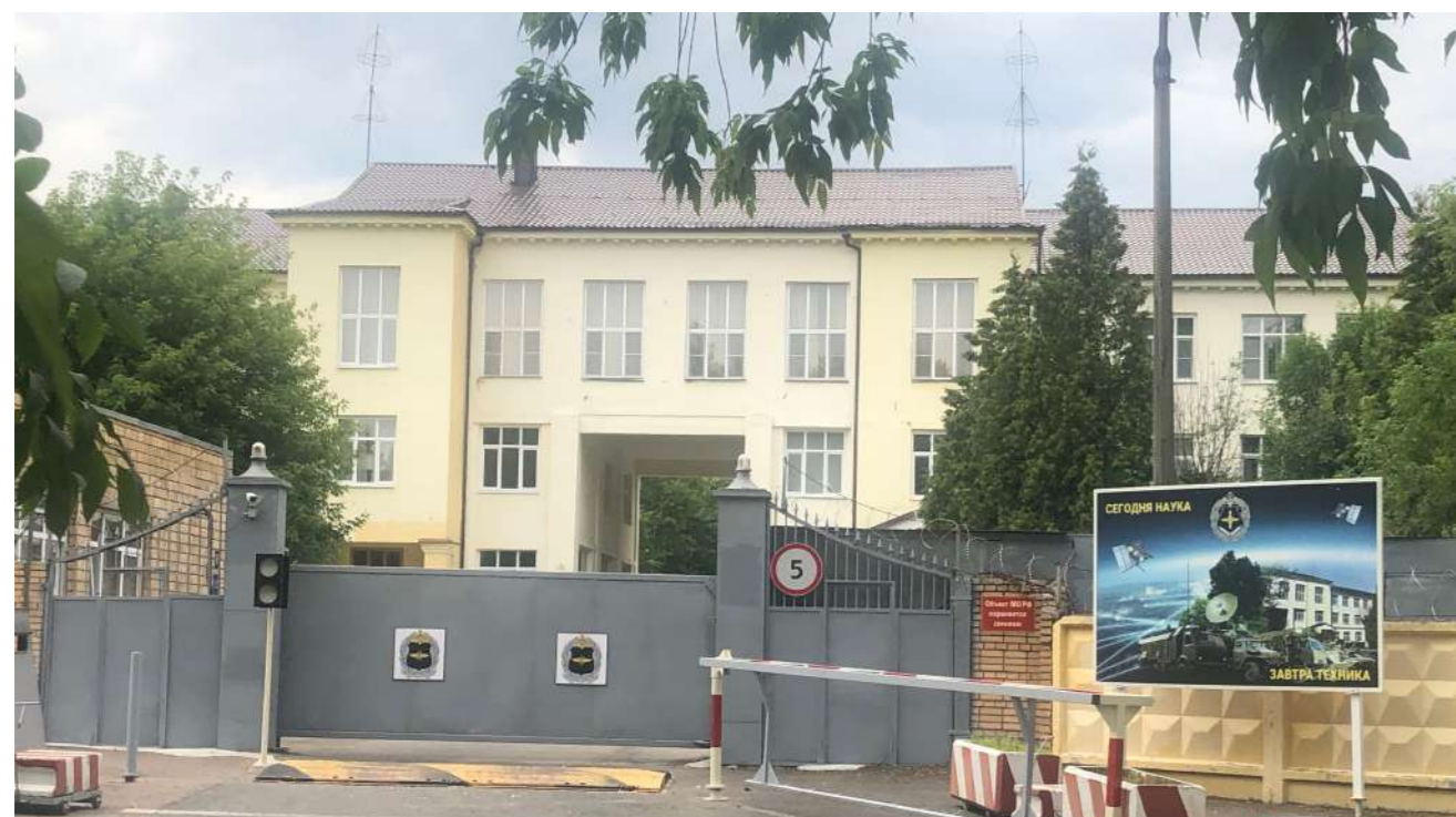
Проектирование капитального ремонта зданий ФГБУ «16 Центральный научно-исследовательский испытательный Орден Красной звезды Институт имени маршала войск связи А.И.Белова» министерства обороны Российской Федерации
