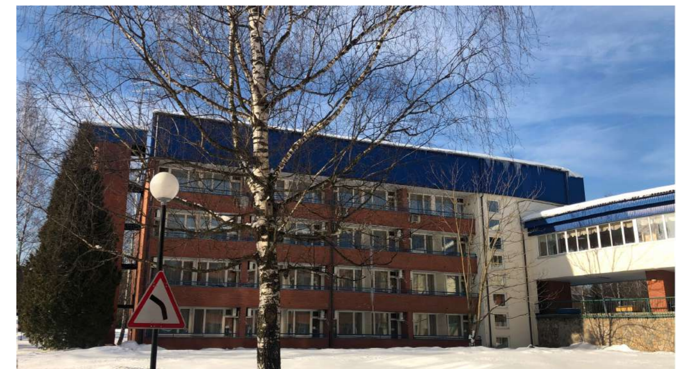
Проектирование капитального ремонта здания ФБЛПУ «ЛРЦ «Подмосковье» ФНС России» по адресу: Московская область, городской округ Мытищи, деревня Аксаково, ул. Подмосковная, владение 1, строение 1
