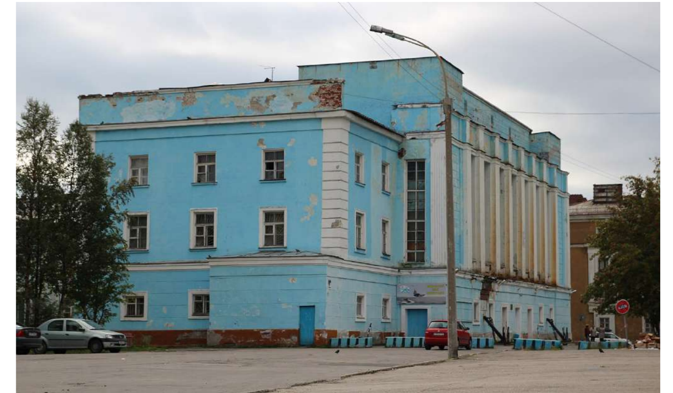
Обследование здания военно-морского музея Северного флота в г. Мурманск.
