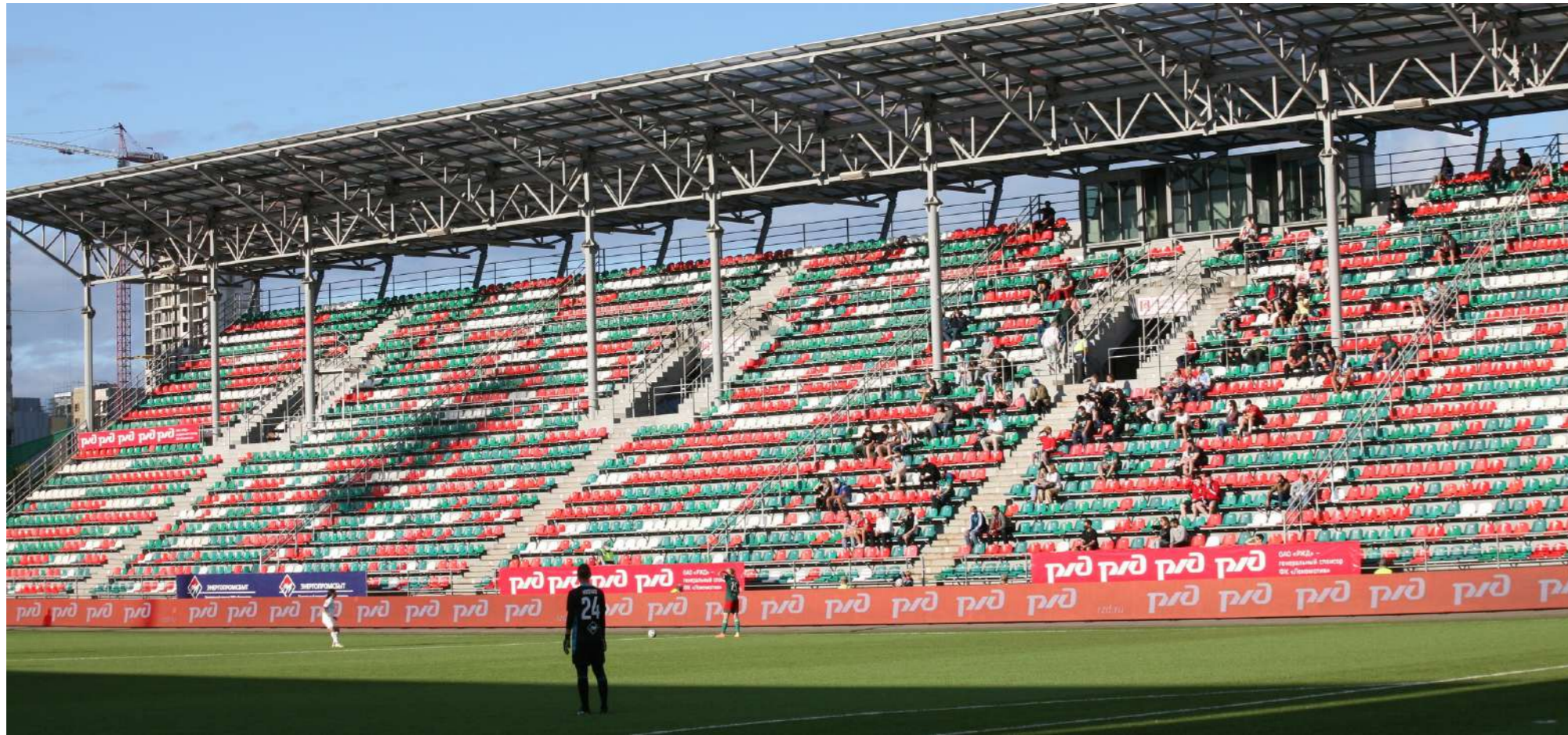
Обследование несущих конструкций трибун «Сапсан Арены»
