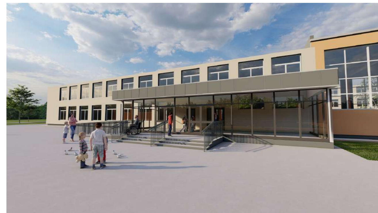
Проектирование капитального ремонта здания МАОУ СОШ № 6, по адресу: Московская область, г. Долгопрудный, ул. Октябрьская, д. 33
