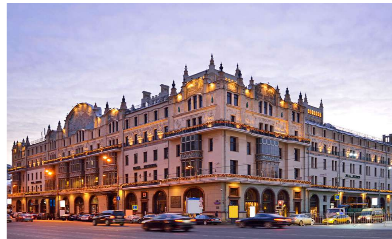
Обследование объекта культурного наследия федерального значения «Здание гостиницы «Метрополь», 1899–1903гг арх. В.Ф. Колькотт, худ. М.А. Врубель».
