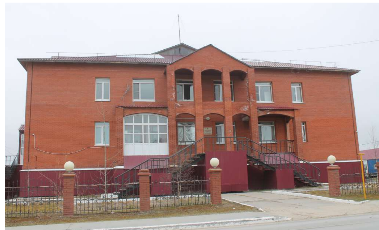
Обследование объекта: «Родильное отделение на 10 коек и соматическое отделение на 50 коек», расположенное по адресу: ЯНАО, с. Красноселькуп, ул. Полярная, д.3, корпус 7
